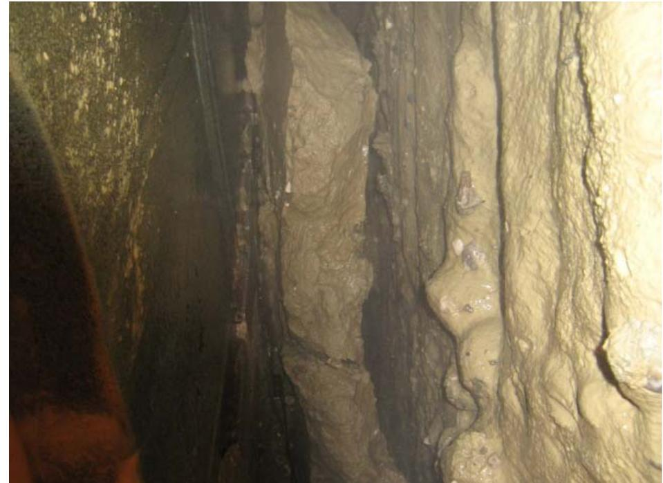
„Pufferung“ durch Verklebungen zwischen Schneidrad und Ortsbrust → Abfall Abbaueffektivität
